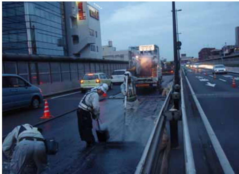
【舗装工事実施状況】
