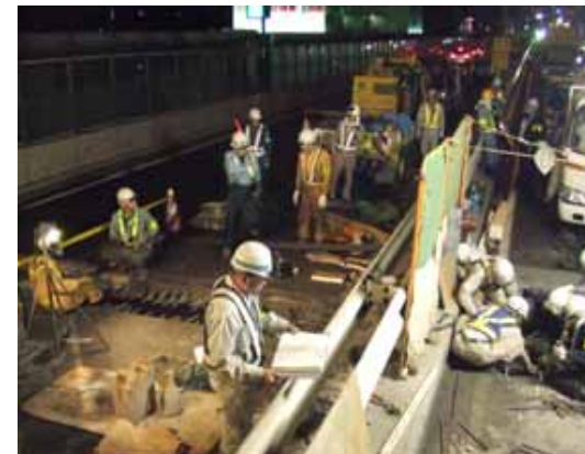
休日24時間規制工事の例
