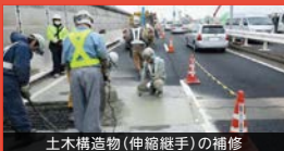
土木構造物(伸縮継手)の補修
