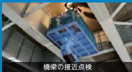
橋梁の接近点検
