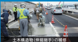
土木構造物(伸縮継手)の補修
