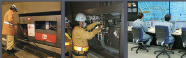
泡消火栓点検
