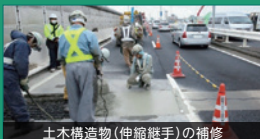
土木構造物(伸縮継手)の補修
