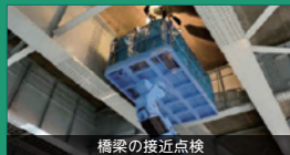
橋梁の接近点検
