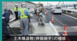
土木構造物(伸縮継手)の補修
