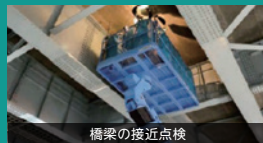
橋梁の接近点検
