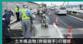
土木構造物(伸縮継手)の補修
