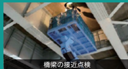
橋梁の接近点検
