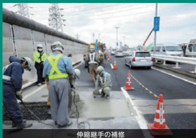
伸縮継手の補修
