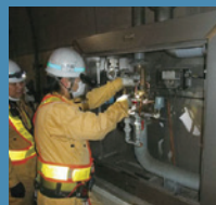
水噴霧装置点検
