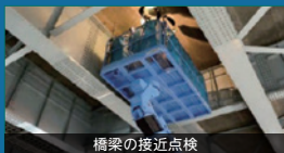
橋梁の接近点検
