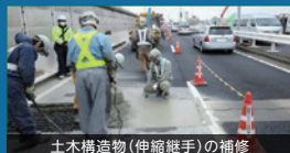
土木構造物(伸縮継手)の補修
