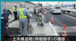
土木構造物(伸縮継手)の補修
