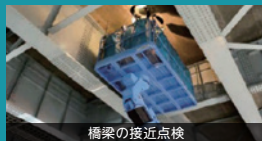
橋梁の接近点検
