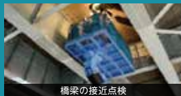
橋梁の接近点検
