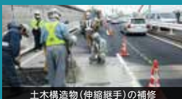
土木構造物(伸縮継手)の補修
