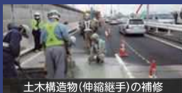
土木構造物(伸縮継手)の補修
