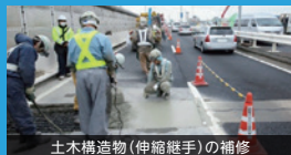
土木構造物(伸縮継手)の補修
