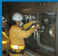
水噴霧装置点検
