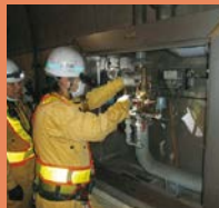
水噴霧装置点検
