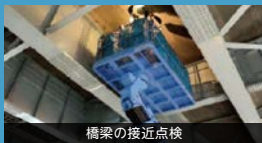
橋梁の接近点検
