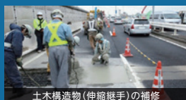
土木構造物(伸縮継手)の補修
