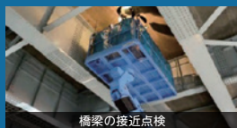
橋梁の接近点検
