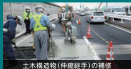
土木構造物(伸縮継手)の補修
