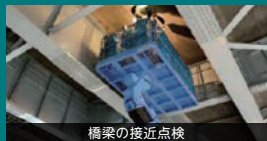
橋梁の接近点検
