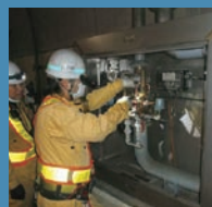
水噴霧装置点検
