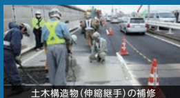
土木構造物(伸縮継手)の補修
