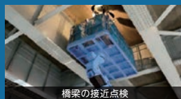
橋梁の接近点検
