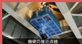
橋梁の接近点検
