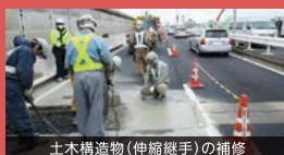
土木構造物（伸縮継手）の補修
