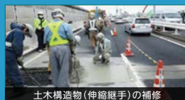
土木構造物(伸縮継手)の補修
