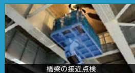
橋梁の接近点検
