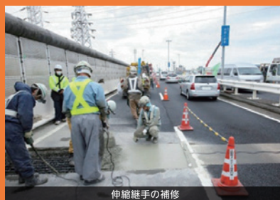
伸縮継手の補修
