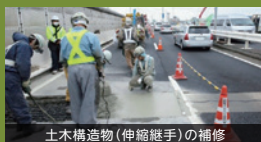
土木構造物(伸縮継手)の補修
