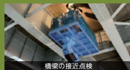
橋梁の接近点検
