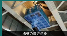
橋梁の接近点検
