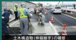
土木構造物(伸縮継手)の補修
