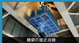
橋梁の接近点検
