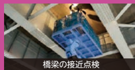
橋梁の接近点検
