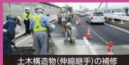
土木構造物(伸縮継手)の補修
