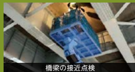
橋梁の接近点検
