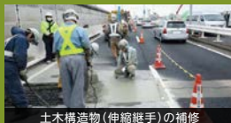
土木構造物(伸縮継手)の補修
