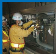
水噴霧装置点検
