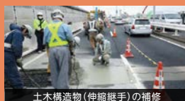
土木構造物(伸縮継手)の補修
