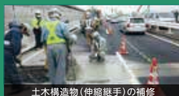
土木構造物（伸縮継手）の補修
