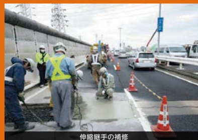
伸縮継手の補修
