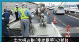
土木構造物(伸縮継手)の補修
