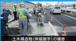
土木構造物(伸縮継手)の補修
