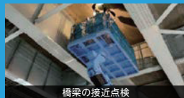
橋梁の接近点検
