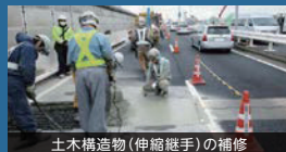
土木構造物(伸縮継手)の補修
