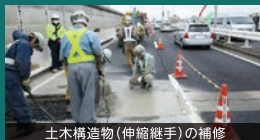
土木構造物(伸縮継手)の補修
