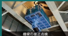
橋梁の接近点検
