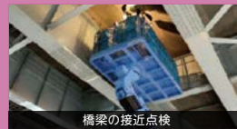
橋梁の接近点検
