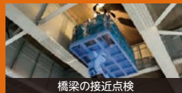
橋梁の接近点検
