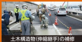
土木構造物(伸縮継手)の補修
