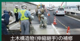
土木構造物(伸縮継手)の補修
