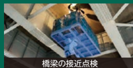
橋梁の接近点検
