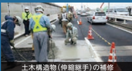
土木構造物(伸縮継手)の補修
