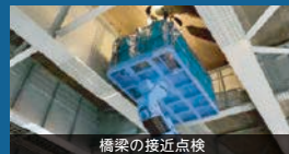
橋梁の接近点検
