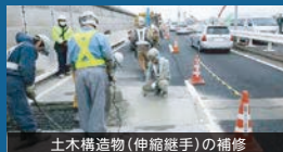
土木構造物(伸縮継手)の補修
