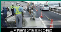
土木構造物(伸縮継手)の補修
