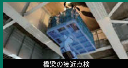
橋梁の接近点検
