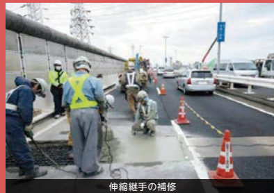
伸縮継手の補修
