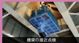
橋梁の接近点検
