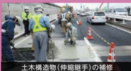
土木構造物（伸縮継手）の補修
