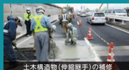
土木構造物（伸縮継手）の補修
