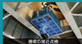
橋梁の接近点検
