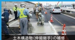
土木構造物（伸縮継手）の補修
