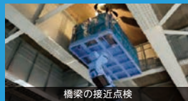
橋梁の接近点検
