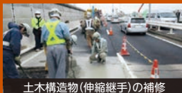
土木構造物（伸縮継手）の補修
