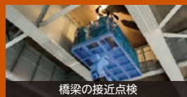
橋梁の接近点検
