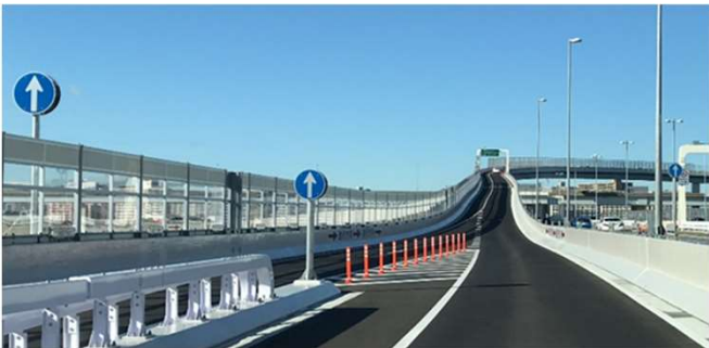
②入口との合流部
